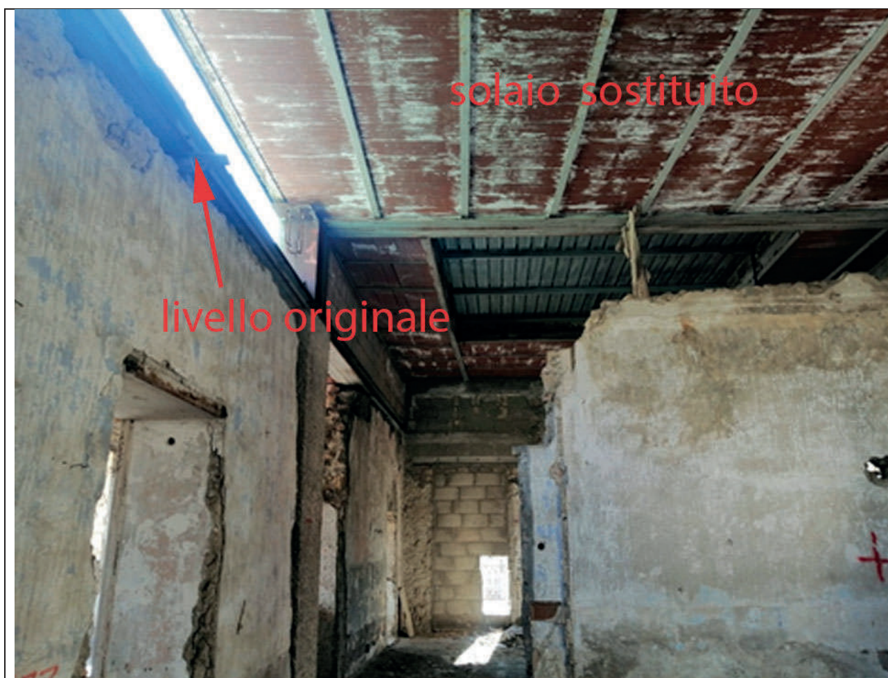
Fig.7 foto del nuovo solaio negli ambienti
